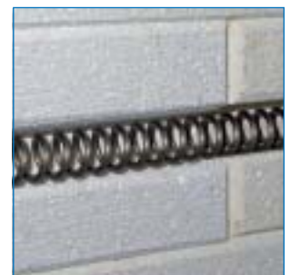
Topná tělesa v drážkách (KE-L a KE-N)
