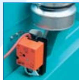
Ovládání přivzdušňovací a odtahové klapky
